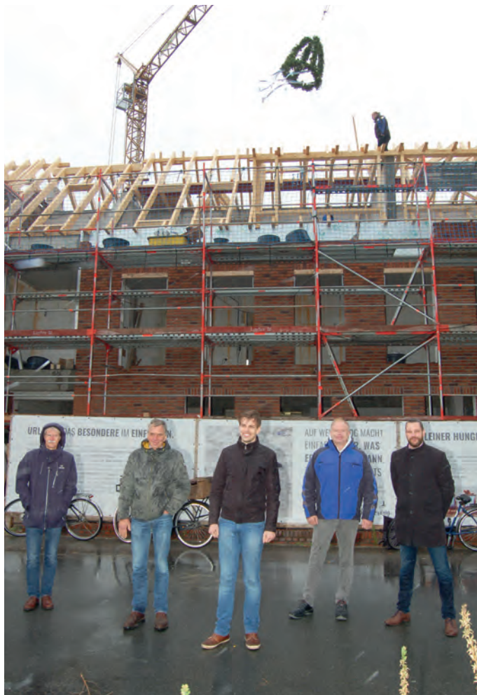
Ganz schön stürmisch: Der Richtkranz neigte sich bedenklich im Sturm, es regnete in Strömen. In der Mitte Bauherr Tobias Orthmann.
